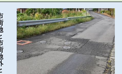
ツギハギだらけの市道の例
